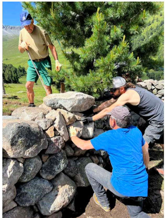
Wiederinstandstellen der Trockensteinmauer und Schutz der Arve
