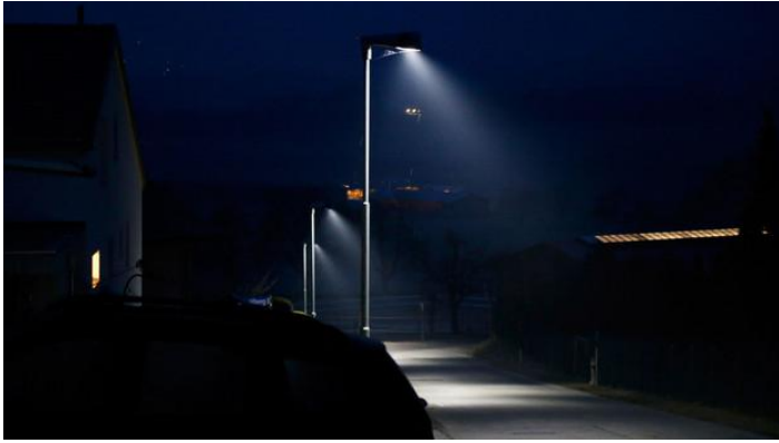
Abbildung 9: LED-Strassenlampen mit präziser Lichtlenkung nach unten (Cantalejo 2013)
