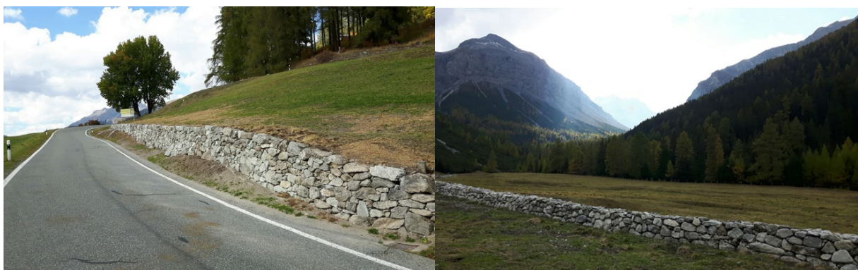
Abbildung 3: links, die sanierte Trockenmauer bei Lüsai; rechts, sanierter Abschnitt der Trockenmauer im Val Vau.
