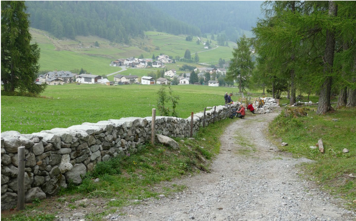
Abbildung 5. Von 2017 bis 2021 wurden in einem Projekt Trockenmauern im Val Müstair saniert. Hier sieht man die letzten Arbeiten innerhalb des Projektes an einer Mauer in Tschieriv (Bild Yves Schwyzer).
