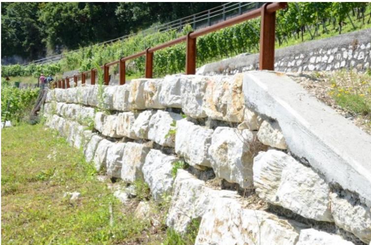
Abb. 20: Die neu erstellten Mauern nach dem Mauertyp „Schafis“ mit den betonierten Horizontalfugen (eigenes Foto: 16.07.2014).
