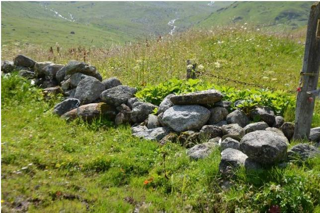
Abb. 14: Die sanierungsbedürftigen Trockensteinmauern auf dem Septimerpass (*eigenes Foto: 06.08.2014*).
