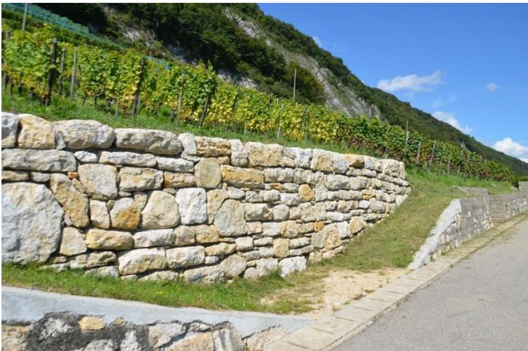
Abb. 22: Das Mauerbild des Typs „Twann“ nähert sich dem Mauerbild einer Trockensteinmauer an (eigenes Foto: 28.08.2014).
