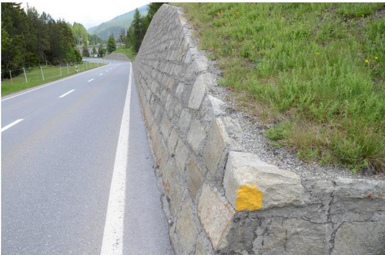
Abb. 4: Natursteinmauerwerke als traditionelles Element im Strassenbau im Engadin, Kanton GR (*eigenes Foto: 11.06.2014*).
