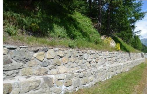
Abb. 30: Die gestufte Stützmauer bei St. Moritz-Bad ist nach hinten versetzt (eigenes Foto: 06.08.2014).
