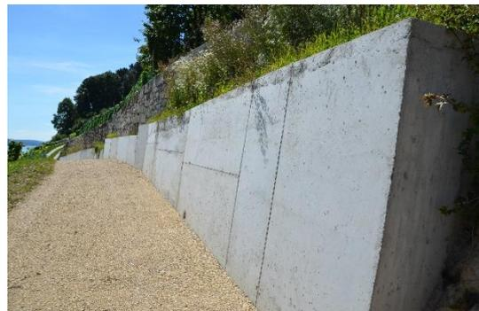
Abb. 24: Betonierte Mauerfussicherungen zum Schutz der wertvollen Trockensteinmauern (*eigenes Foto: 28.08.2014*).
