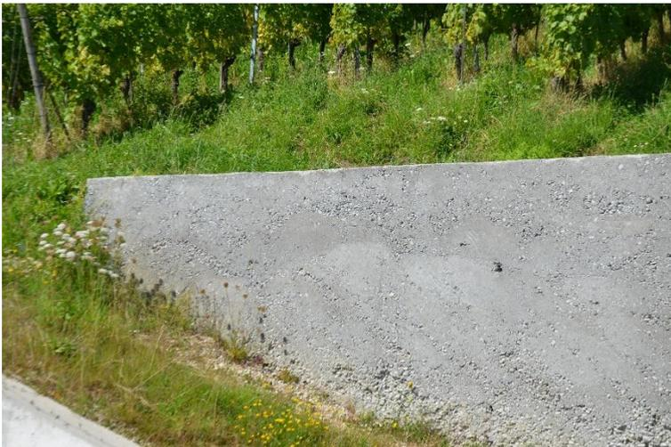
Abb. 23: Eine neu erstellte Stampfbetonmauer am Neuweg (*eigenes Foto: 28.08.2014*).
