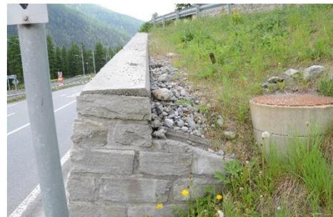
Abb. 38: Eine mit Zement überdeckte Mauerkrone (in Ciuos-chel) (eigenes Foto: 11.06.2014).
