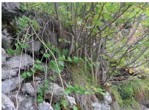
Zerfall der Mauern durch Gehölze
