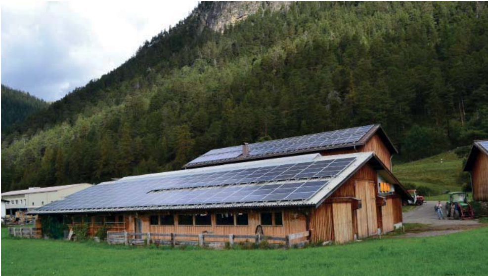
Solarzellen auf dem Dach: Kompromiss zwischen Landschaftsbild und erneuerbarer Energie?
