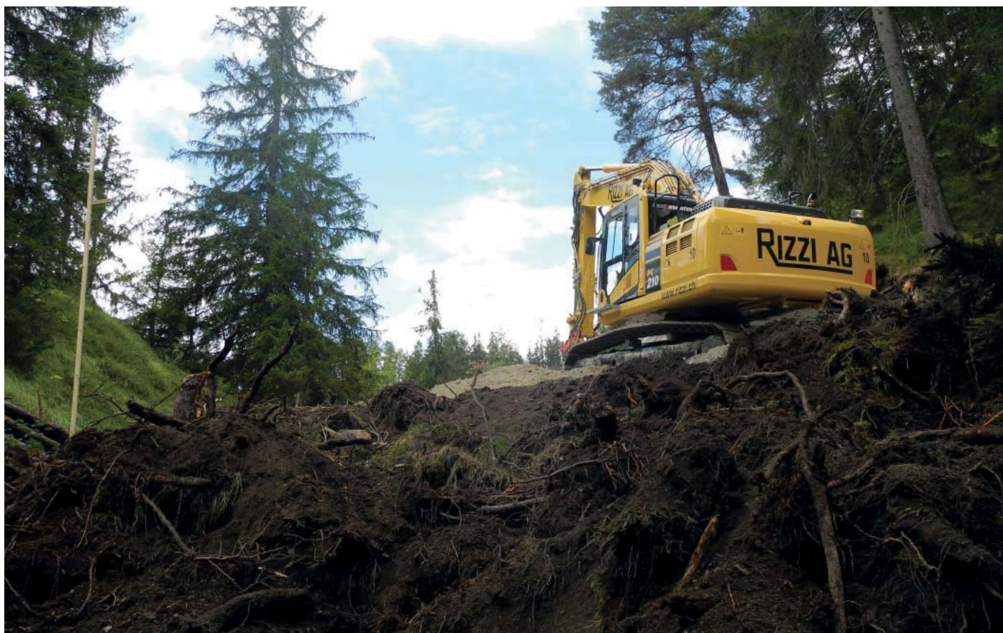
Arbeiten an der Forststrasse (Foto: Roman Flück)
