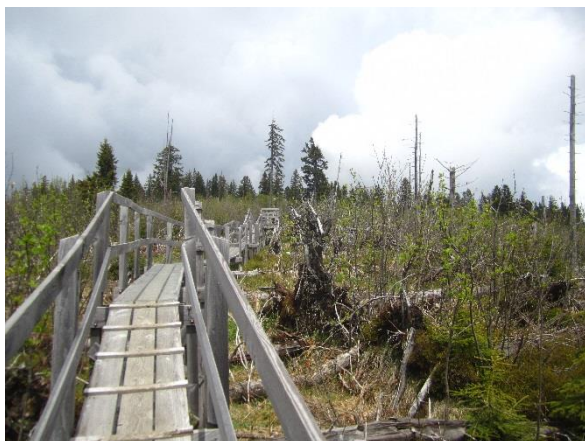
Abb. 14: Gaggersteg in der Nähe der Teilfläche 4
