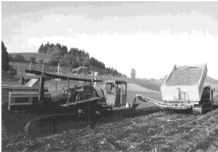
Erneuerung der Drainagen (Foto R. Michel, 1988)
