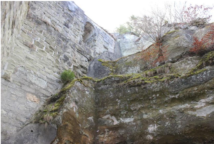
Abbildung 63: Ausgangspfortchen zum Nebenhaus in der Westwand (Quelle: eigene Fotografie, 2020)
