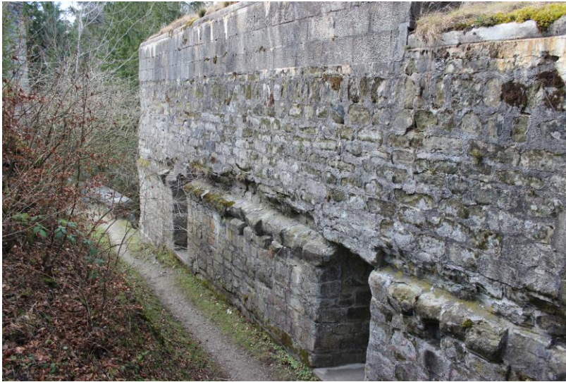
Abbildung 50: Doppelgeschossige Wehrgänge der nördlichen Ringmauer (Quelle: eigene Fotografie, 2020)
