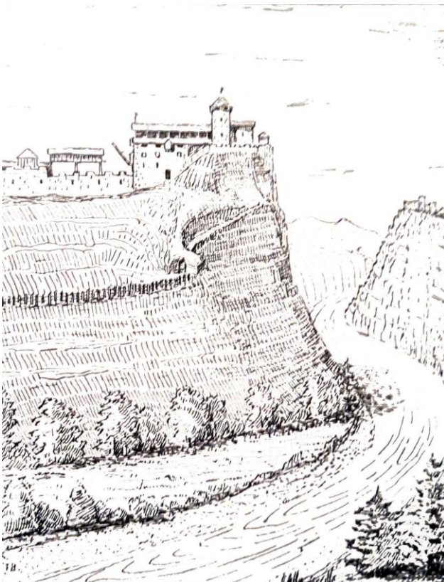
Abbildung 66: Nordansicht der Hauptburg (Quelle: Burri, 1935, S. 231)
