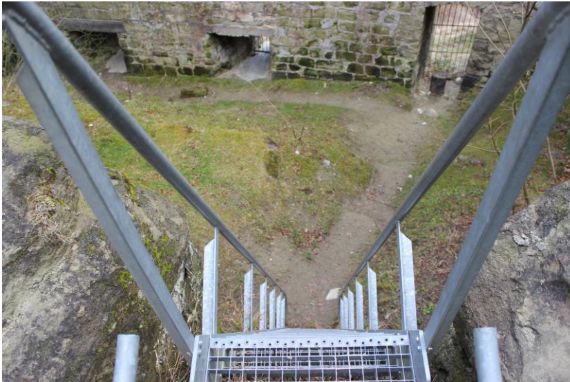
Abbildung 59: Unterstes Kellergeschoss des Donjons (Quelle: eigene Fotografie, 2020)
