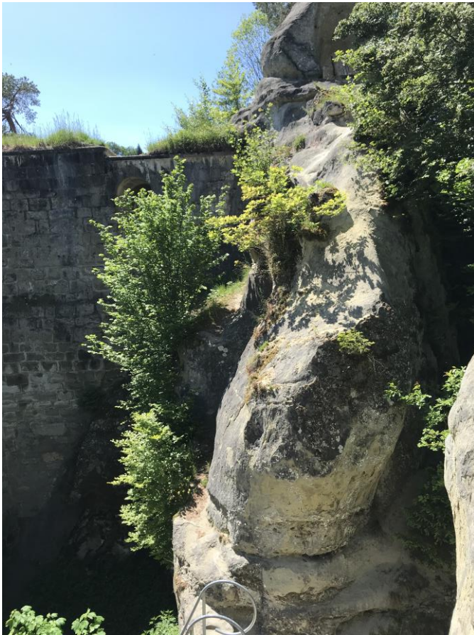
Abbildung 67: Ort der einstigen Treppe zum hinteren Teil der Garita (Quelle: eigene Fotografie, 2020)
