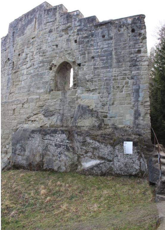
Abbildung 55: Ostfassade der Hauptburg (Quelle: eigene Fotografie, 2020)
