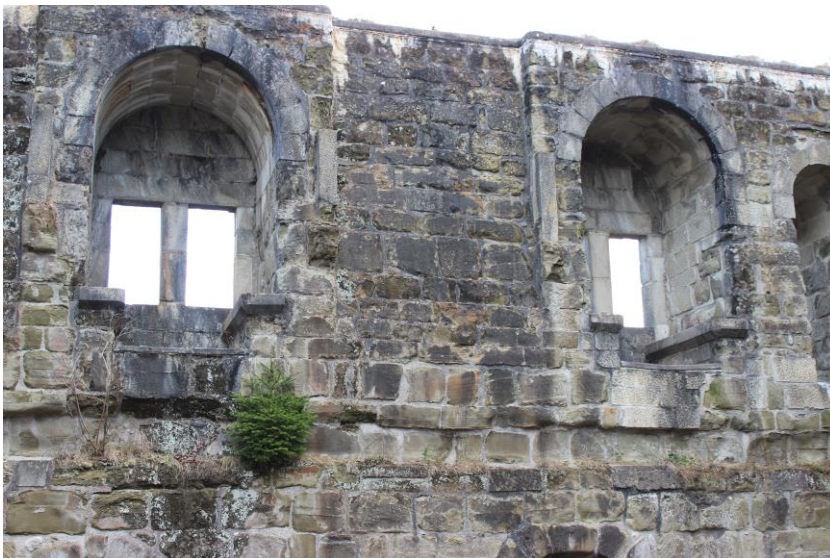
Abbildung 64: Kamin zwischen rechter und mittlerer Fensternische im Saal des Donjons (Quelle: eigene Fotografie, 2020)
