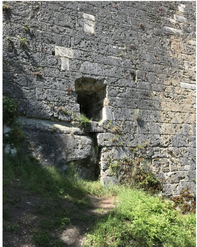
Abbildung 13: Standort von Station 6 (Quelle: eigene Fotografie, 2020)
