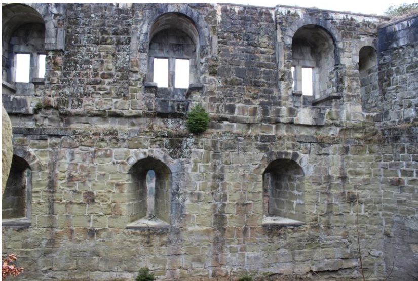
Abbildung 60: Schießscharten im oberen Kellergeschoss und Fensternischen im dritten Stock (Quelle: eigene Fotografie, 2020)
