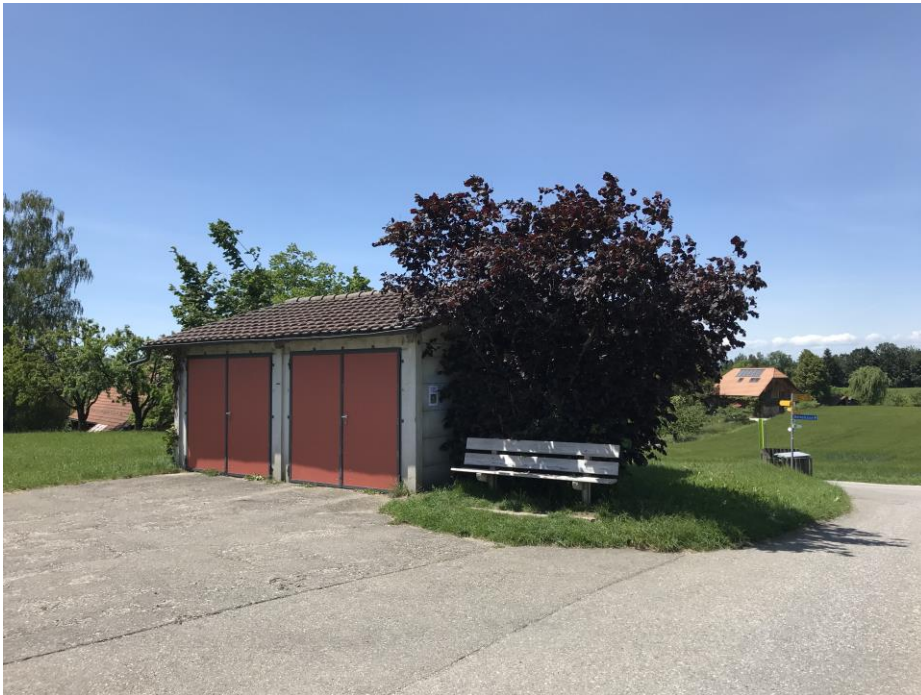
Abbildung 10: Standort von Station 3 (Quelle: eigene Fotografie, 2020)
