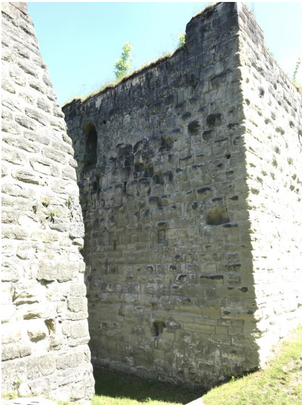
Abbildung 45: Löcher in Nordwand des vorderen Turms als Hinweis auf Treppe (Quelle: eigene Fotografie, 2020)
