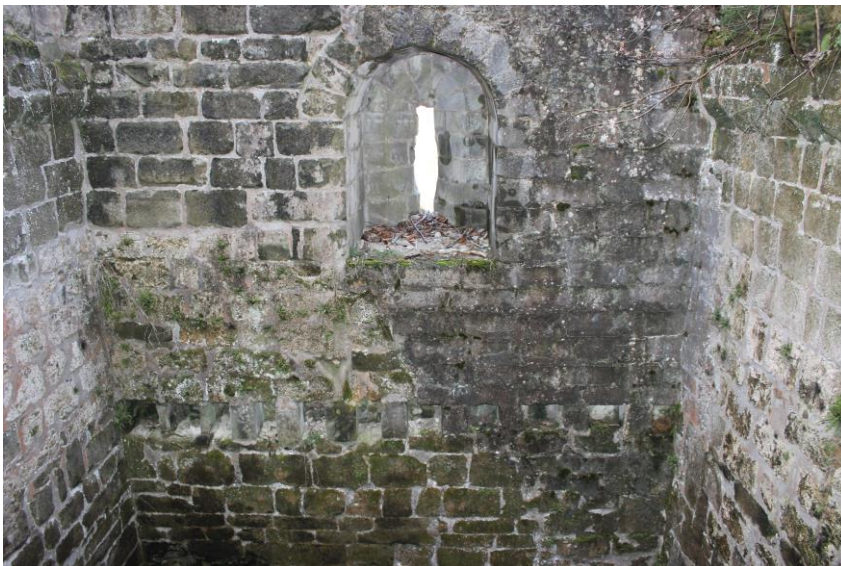
Abbildung 43: Zweites Stockwerk des vorderen Turms (Quelle: eigene Fotografie, 2020)
