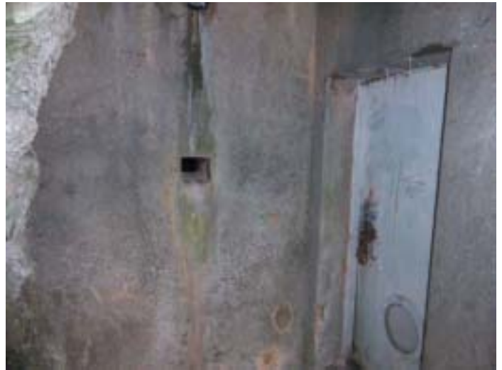
Photo 3 : des trous pour lancer les grenades sont bien souvent les seules possibilité d'accès. Fort du Pont du Roc 4,
