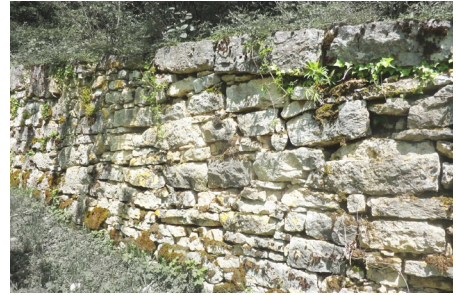
Abb. 44 Gut erhaltene Trockensteinmauer
