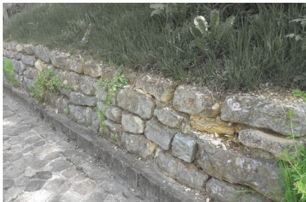
Abb. 27 Trockensteinmauer
