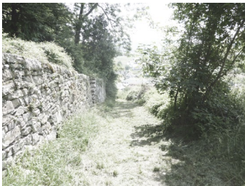
Abb. 61 Die Trockensteinmauern auf der Talseite sind heute grösstenteils überwachsen.
