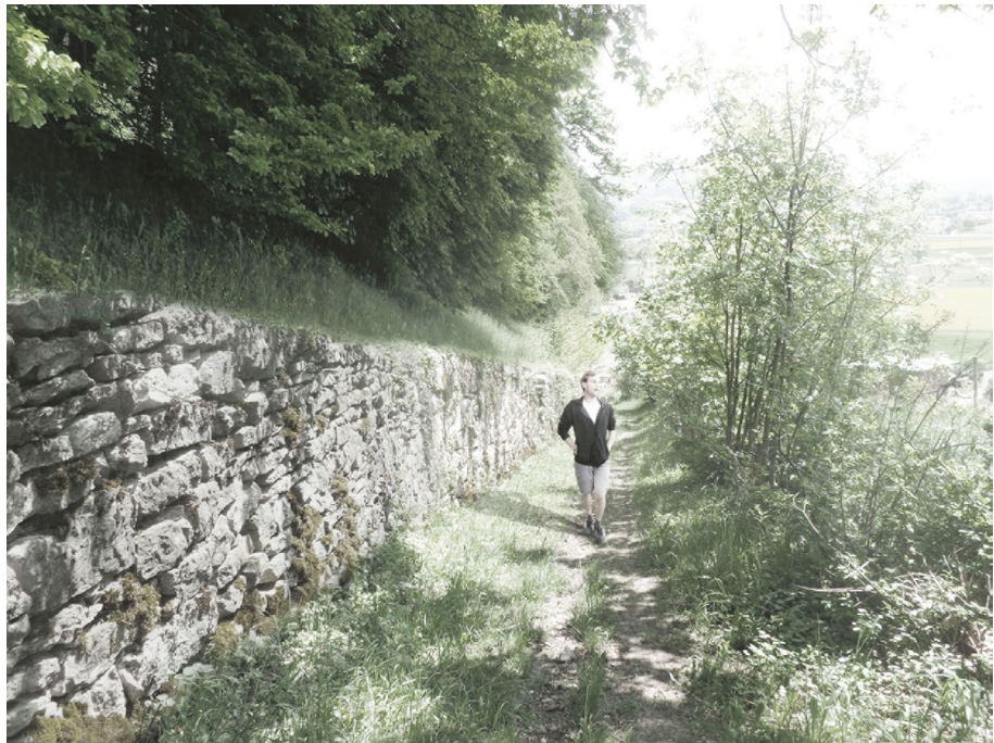
Abb. 52 ...und nachdem die Mauerkrone und die Oberfläche vom Bewuchs befreit sind.
