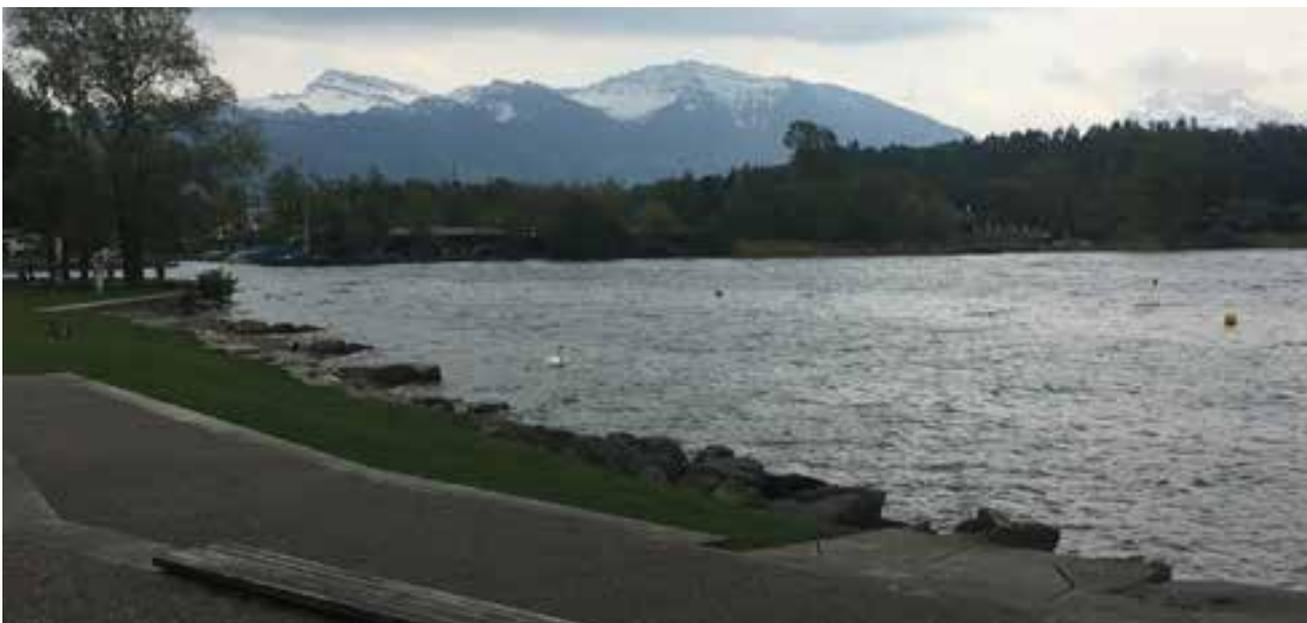
Abbildung 24: Badestrand mit Blockwurf zum Uferschutz in Schmerikon am Obersee
