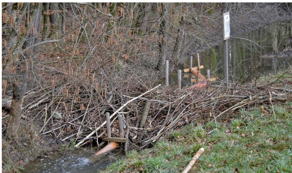
Abb. A17 > Drainage zur Wasserstandregulierung in einem Biberdamm
