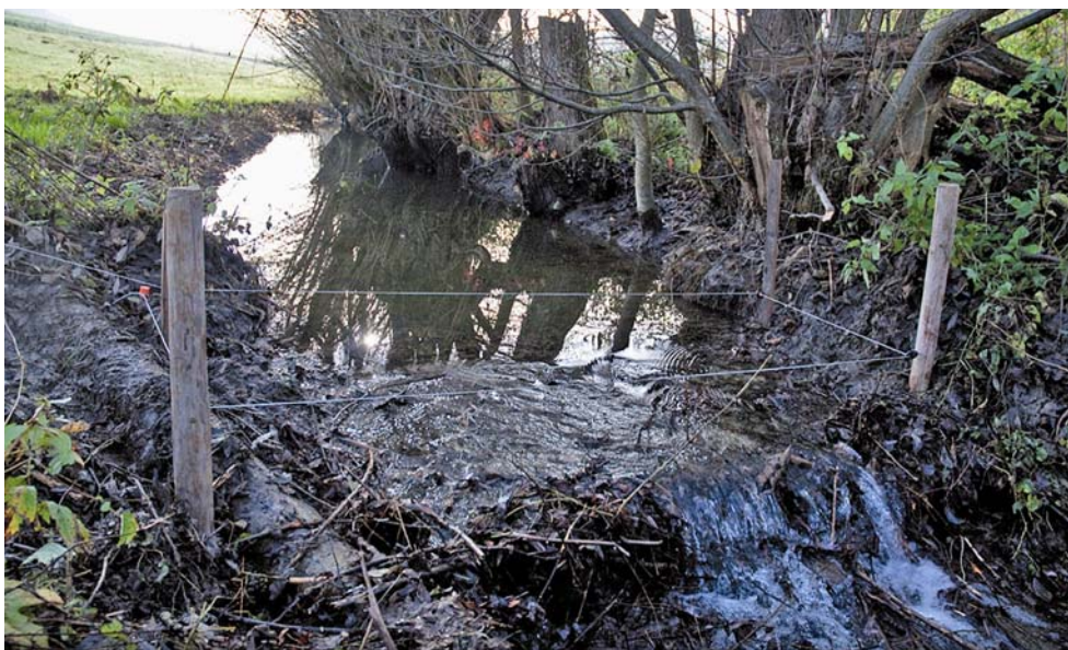
Abb. A18 > Elektrozaun auf der Dammkrone eines Biberdamms
