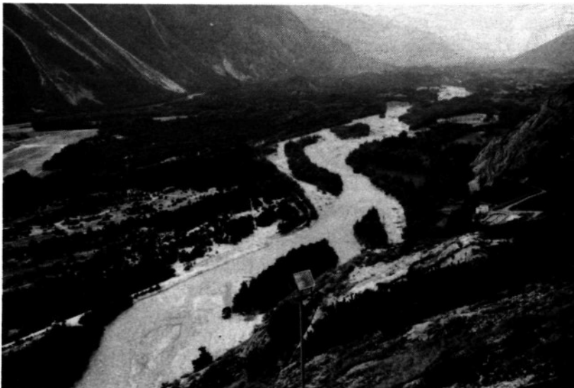
Bild 5. Blick von der Kirche von Varen. Die durch die Vegetation fixierte Insel im Vordergrund lenkte die Strömung des Hochwassers vom August 1987 auf den linksseitigen Damm, der dem Angriff nicht standhielt. Ausgedehnte Überschwemmungen des unteren Pfynwaldes und von Teilen des Pfingutes (am linken Bildrand) waren die Folge.
