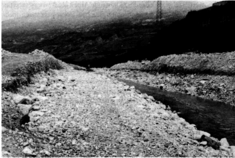
Bild 3. Im November 1986 füllte ein grösserer Murgang des Illgrabens das Rottengerinne - für den Fluss musste eine Rinne durch die Ablagerungen gebaggert werden.
