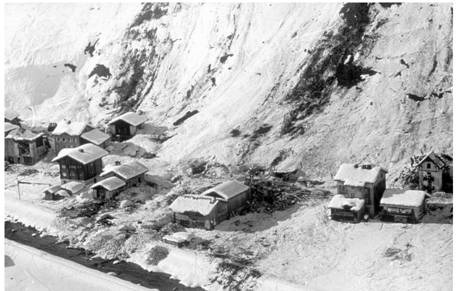
Abb. 5. Die Unglückslawine von Vals (Graubünden) vom 20.1.1951 brach unterhalb der Leisalp an. In drei total zerstörten Wohnhäusern starben 19 Personen (Foto Archiv SLF).
