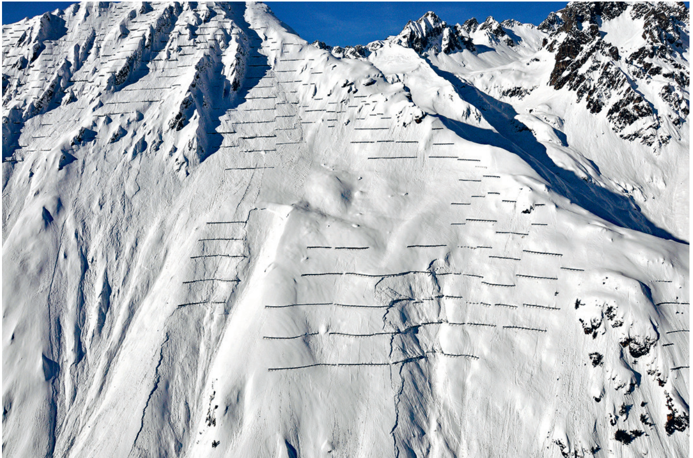
Abb. 10. Am Geissberg (Uri) brachen am 22. Januar 2018 etliche Lawinen in- und ausserhalb der Stützverbauung an. Die Stützwerke bremsten die Schneemassen ab und verhinderten einen noch grösseren Anbruch. Die Lawinen stoppten ausserhalb des Siedlungsgebietes von Gurtellen und richtete keine Schäden an (Foto S. Margreth, SLF, 24.1.2018).
