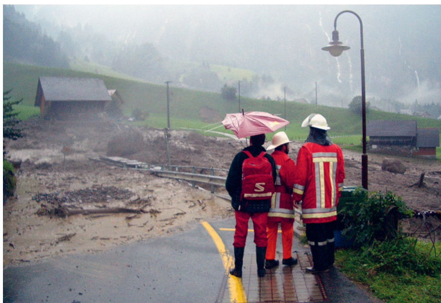
Abb. 6. Strassenposten der Milizfeuerwehr und Passant an der Kantonsstrasse in Oberriedenbach, Nidwalden, während eines Murgangs am Haldibach 2005. Foto: Fotosammlung Tiefbauamt NW.
