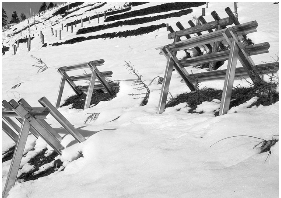
Abb. 6. SLF-Versuchsverbau Dorfberg (Graubünden). Ab dem Jahre 1952 wurden neue Verbautypen aus unterschiedlichen Baumaterialien wie Aluminium und Holz getestet (Foto Archiv SLF).
