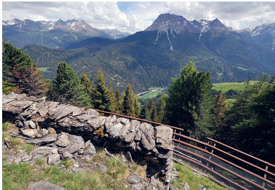
Abb. 2. Die erste technische Verbauung eines Lawinenanrissgebiets in der Schweiz unterhalb des Motta d'Alp oberhalb von Martina (Graubünden). Im Vordergrund eine der 19 Steinmauern, die 1868 von Coaz projektiert wurde. 1987 wurden die Mauern mit Stahlschneebrücken ergänzt (Foto S. Margreth, SLF).
