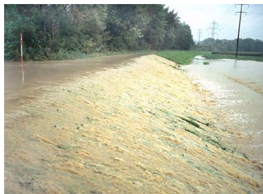
Abbildung 2.16: Hochwasserauswirkungen an der Reuss: überspülter Damm bei Jöns, AG, August 2005 (Foto: B. Schelbert, Departement Bau, Verkehr und Umwelt, Kanton Aargau, Abteilung Landschaft und Gewässer).
