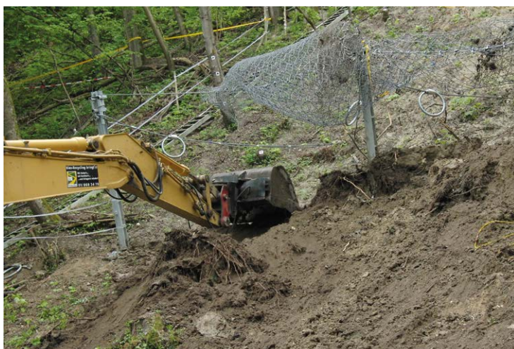
Purge d'un filet de protection contre les coulées de boue du côté aval à l'aide d'une pelleuse.
