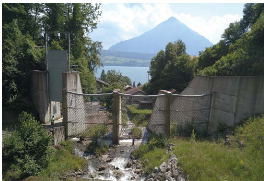
Barrière, côté amont (Image: [F]).
