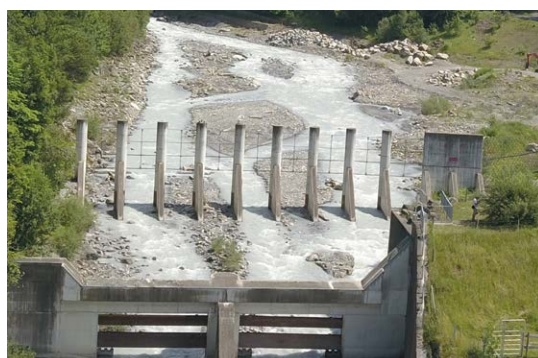
Barrière, côté aval (Image: [F]).
