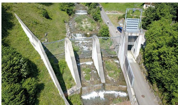
Ouvrage à filet avec murs en béton longitudinaux
