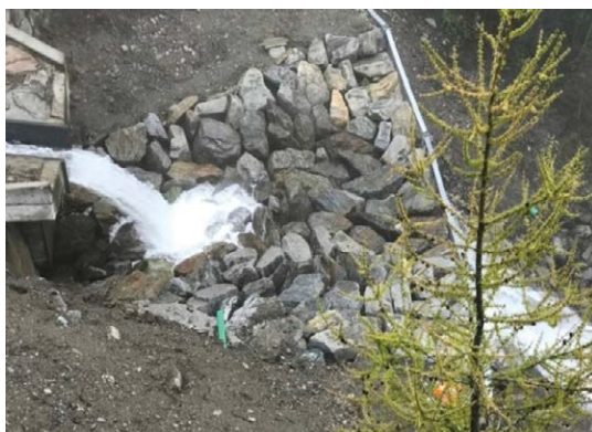
Barrière pré-remplie à l'aide de gros blocs, vue d'en haut (Image: [I]).
