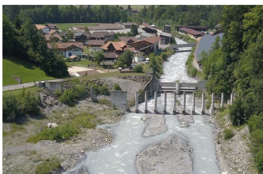
Barrière, côté amont (Image: [F]).
