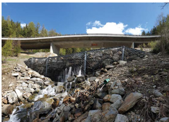
Barrière UX-180-H6 pré-remplie, vue d'aval (Image: [G]).
