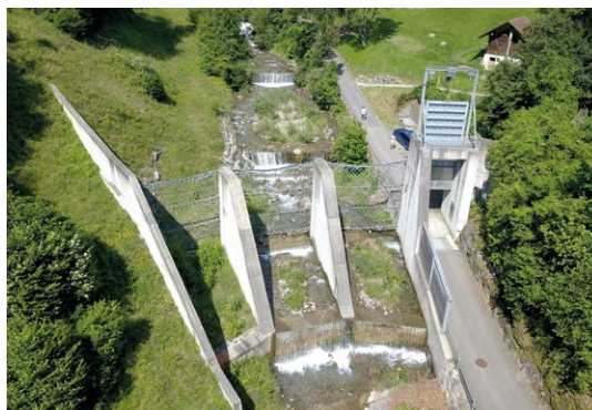
Barrière, côté aval (Image: [F]).
