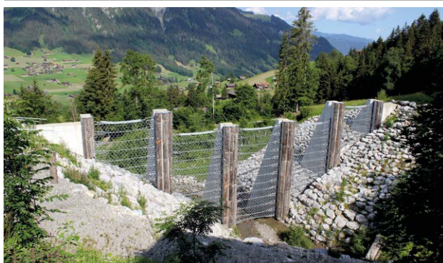
Ouvrage à filet avec piliers en béton
