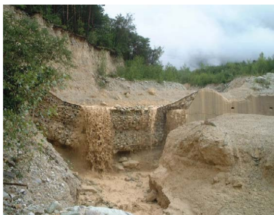
Barrière VX remplie, tronçon d'aménagement 1 (Image: [G]).
