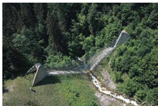
Sperre unterwasserseitig (Bild: [F]).
