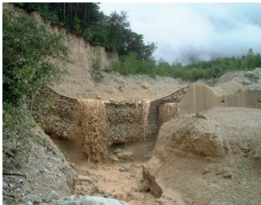
Sanierungsabschnitt 1 mit VX-Barriere gefüllt (Bild: [G]).
