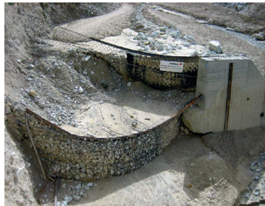
Zweite Sanierung des Mauerflügels und Installation einer weiteren VX Barriere, welche am Rand teilweise verfüllt wurde. (Bild: [A]).
