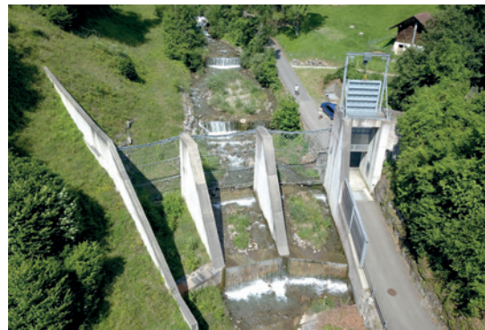
Sperre unterwasserseitig (Bild: [F]).
