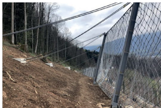
Blick in den Rückhalteraum (Bild: [H]).
