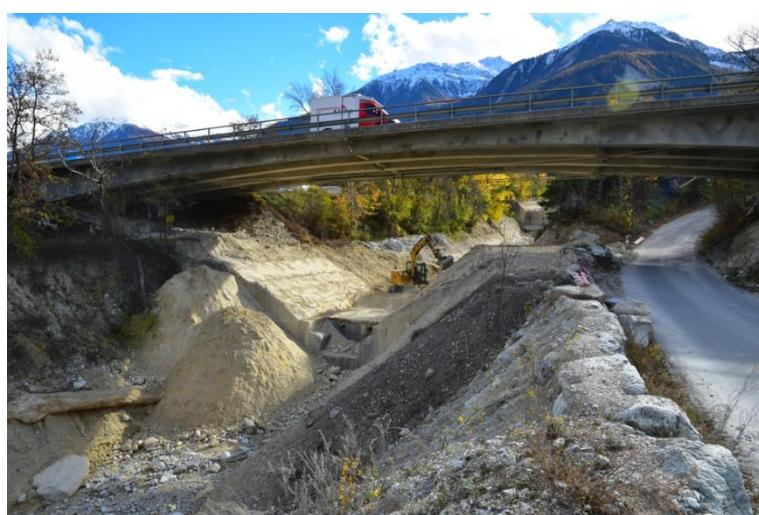
Im Rahmen eines Investitionsprojektes der Eidg. Forschungsanstalt WSL wird nun eine neu konzipierte Messeinrichtung am selben Standort unter der Kantonsstrassenbrücke gebaut. Aktuell wird die Aussparung für die neue Messeinrichtung vorbereitet. Die neue Stahlkonstruktion wartet in Turtmann bereits auf ihren Einbau in den nächsten Monaten. Erfahrungen aus
