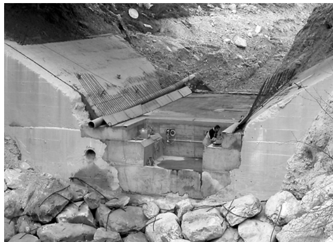
Bild 1: Sanierung der Sperre bei der Kantonstrassenbrücke in Leuk-Susten / VS. links: Sperre vor der Sanierung im November 2003. rechts: Sperre nach der Sanierung im November 2003. Gut sichtbar ist die vorbereitete Aussparung für die Murgangwaage.
