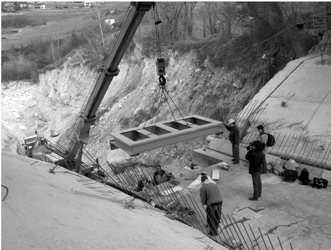
Bild 2: Einbau der Murgangwaage mit Hilfe eines Pneukrans. Die massive Stahlkonstruktion ist hier noch ohne Platte zu sehen. Sie passt millimetergenau in die vorbereitete Öffnung in der Sperre.
