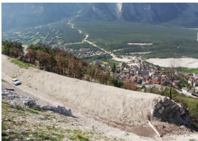
Fig. 7. Deux digues d'une hauteur efficace de 3 m furent construites afin de protéger la ville de Loèche et la route cantonale Loèche-Loèche-les-Bains.
