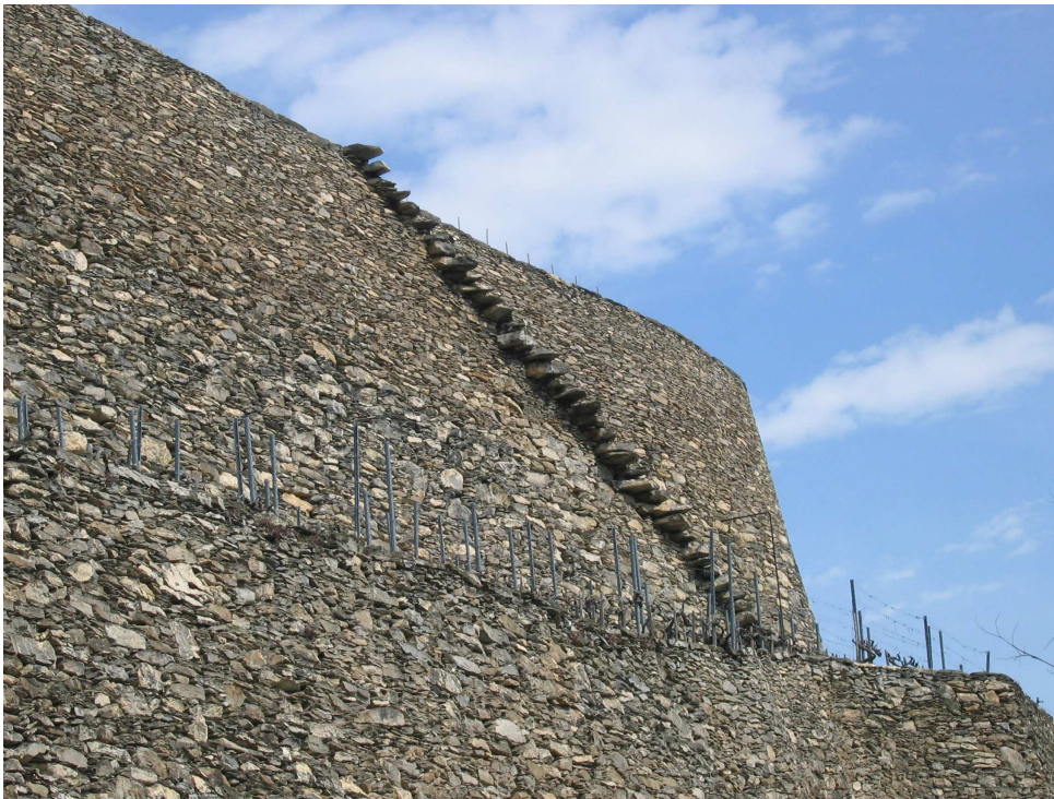
Abbildung 4.9: Die 16 m hohe Mauer vom Weinberg La Cotsetta
