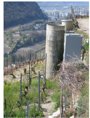
Betonauffangbehälter an der Bisse de Clavoz.
