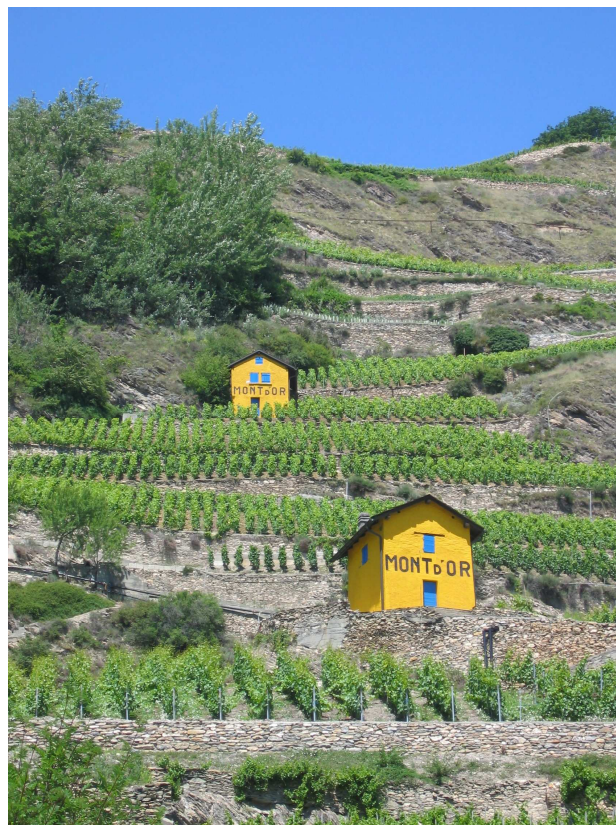
Abbildung 4.6: Die Mauerwerkrebhäuser des Domaine du Mont d'Or am Montorge
