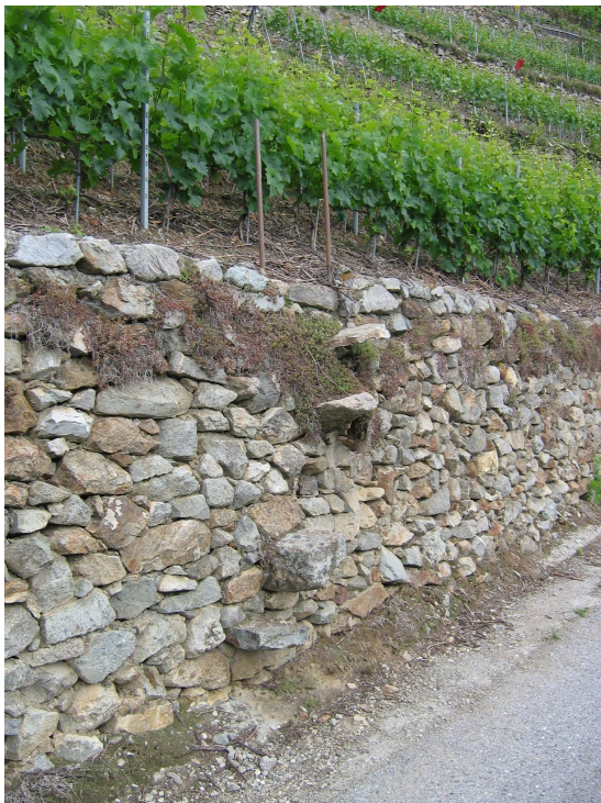
Abbildung 4.15: Weinbergtreppe Typ T8 (Kragarm) in Fully
