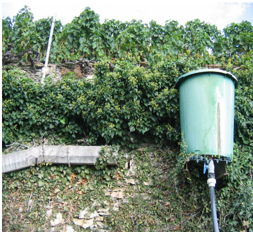
Plastikauffangbehälter für das Wasser aus den Suonen. Links die alten Betonkanäle für die Verrieselung.
