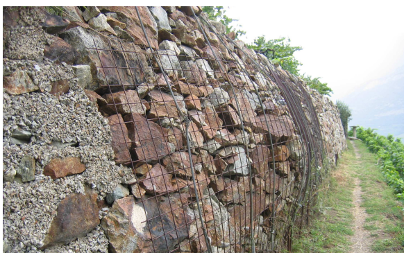
Einem drohenden Einsturz einer Trockenmauer wird versucht mit Vermörtelung (links im Bild) und Stahlträgern entgegenzuwirken.
