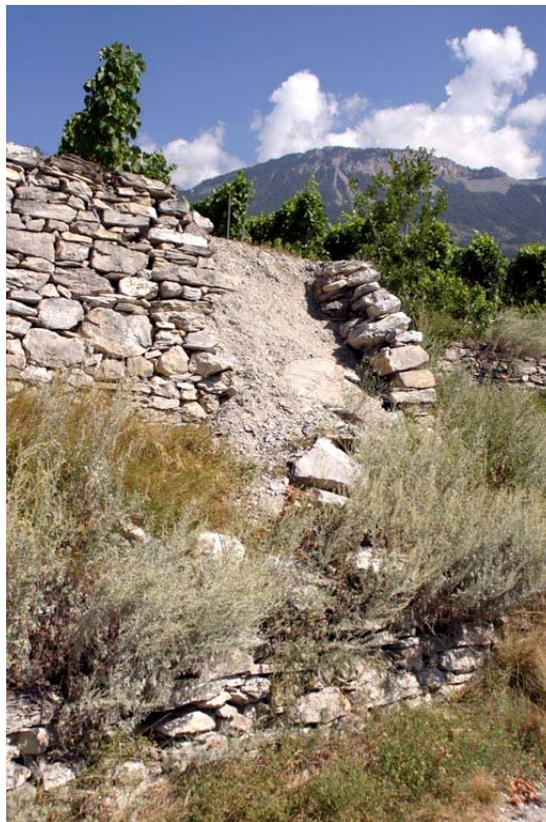
**Abbildung 4.9:** Eingestürzte Trockenmauer
