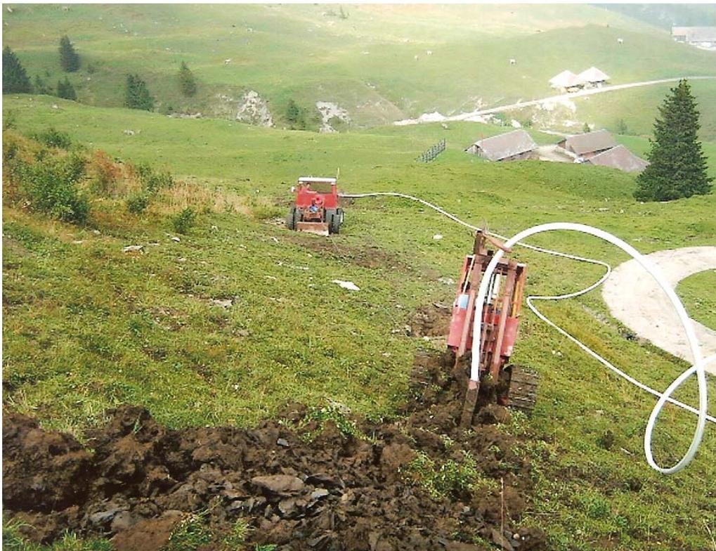
Abbildung 9: Unterirdische Verlegung von mehr als 5000 Metern Stromleitung im Gelände. Im Hintergrund die Fluonalp (Foto: Pia und Bruno Burch).
