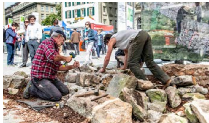
Trockensteinmauerbau am Pärke-Markt
