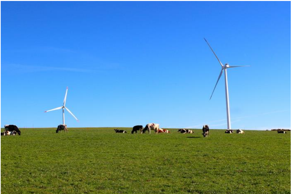
Windenergieanlagen auf dem Mont-Soleil
