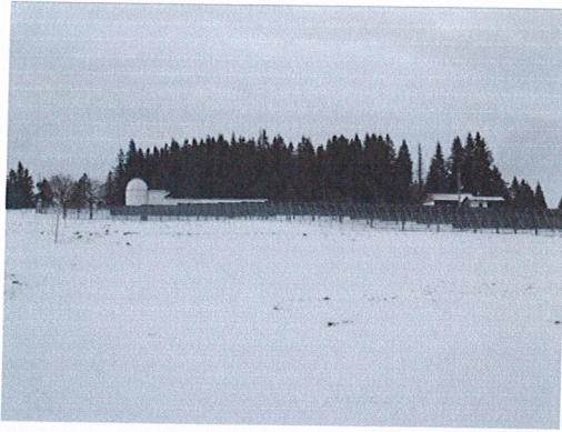
Abbildung 25: Fotovoltaikanlage und Sternwarte auf dem Mont Soleil
