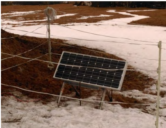
Abbildung 12: Solarpanel für die Stromversorgung
