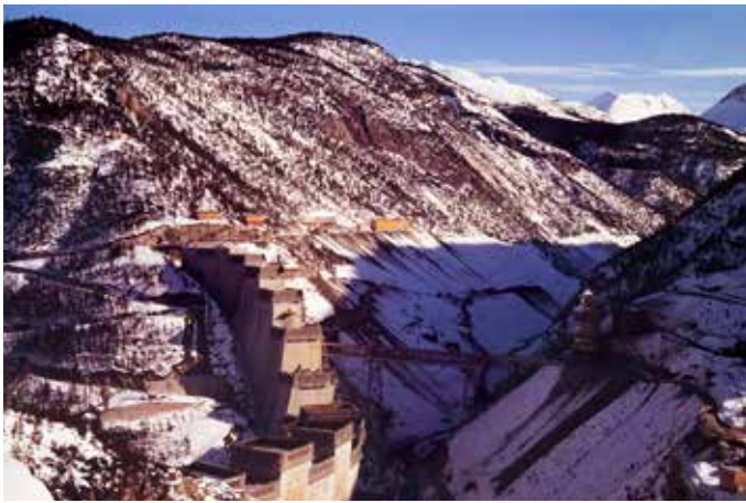
Punt dal Gall, die Staumauer im Bau mit Schnee, 14. November 1966.
