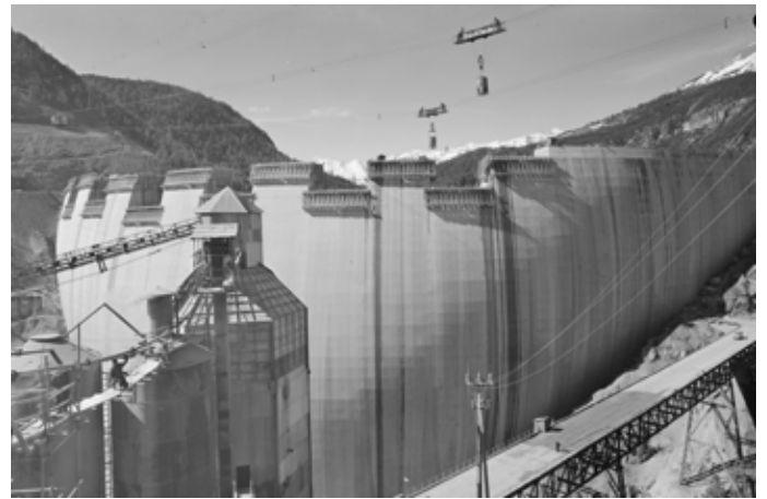
Punt dal Gall, Staumauer im Bau, 14. Mai 1965.
