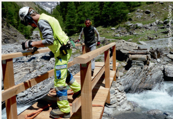
Brückenbau in der Val Trupchun
