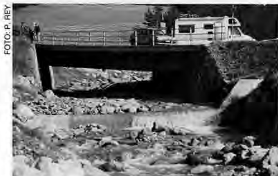
Foto 3: Schwelle der Brückensicherung beim Hotel Il Fuorn.
