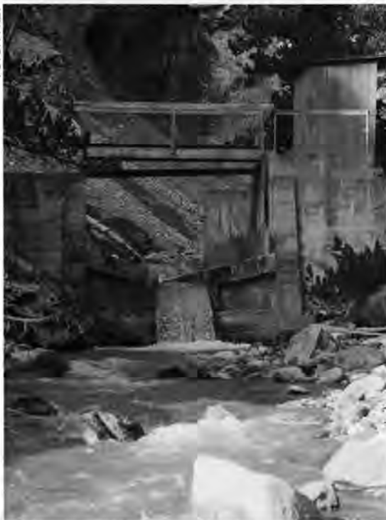
Foto 2: Schwelle der hydrologischen Messstation bei Punt la Drossa.
