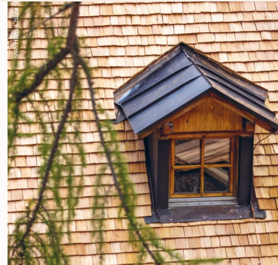
Wie zu alten Zeiten ist das Dach der Haupthütte wieder mit handgespaltenen Lärchenschindeln gedeckt.
