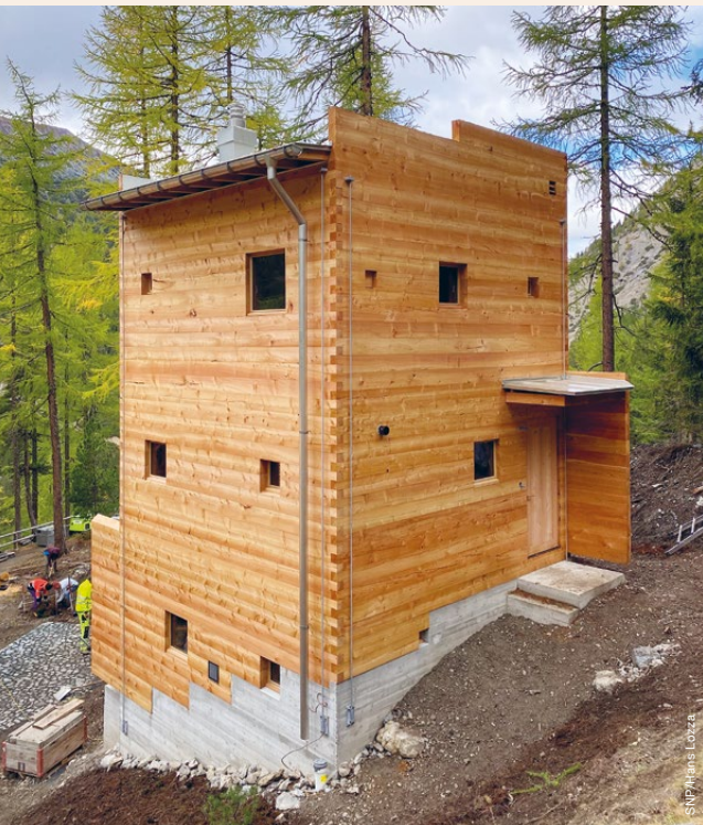
Der neue, in Strickbauweise erstellte Wohnturm ist seitlich versetzt hinter der bestehenden Hütte platziert.
