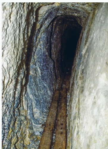
Abb. 1 Mine am Munt Buffalora mit Schienen aus Lärchenholz
