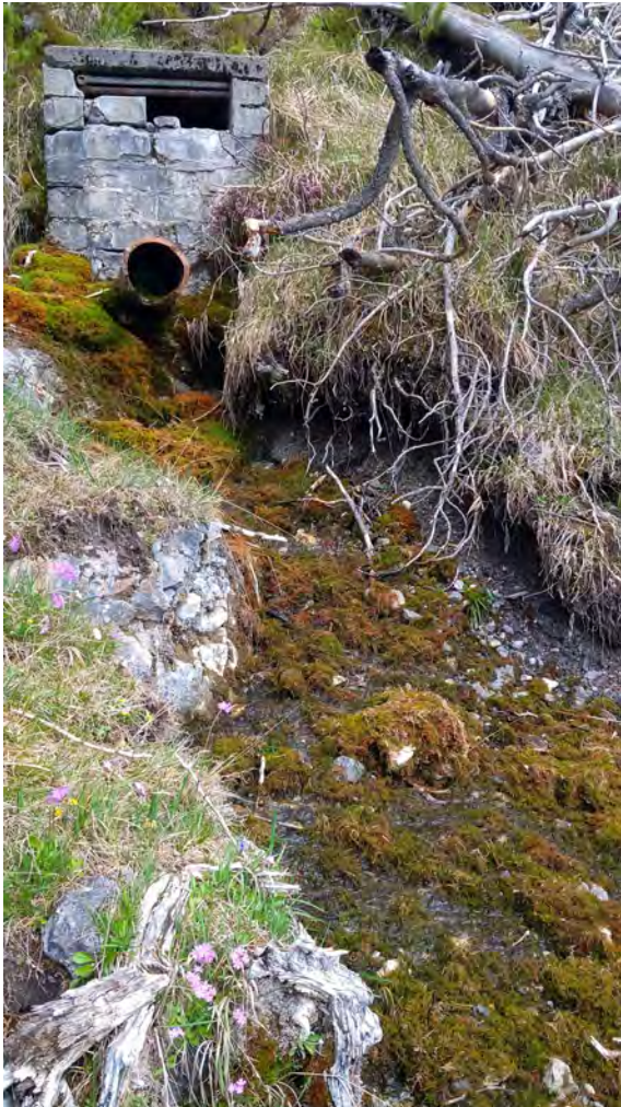
Abbildung 3 Quelle VF1, gefasst durch ein Rohr. Foto: Stefanie von Fumetti (2023)
