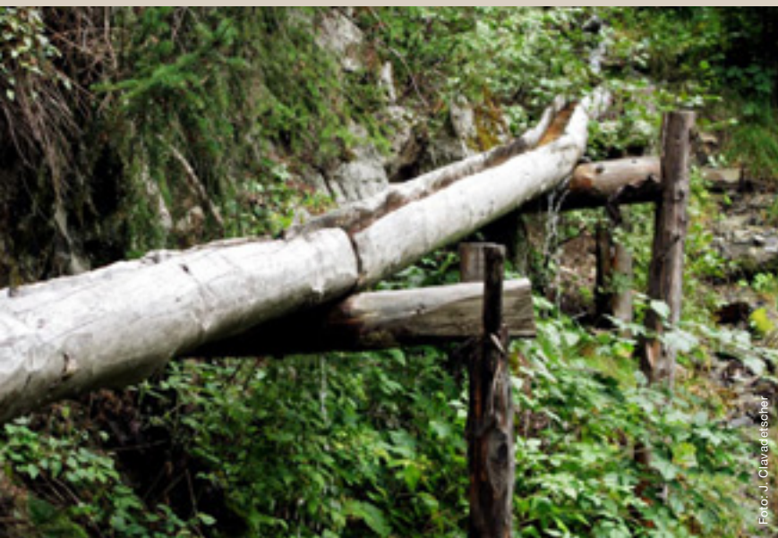
Bei der Fassung des Aual Foppumvasch wurden neue Holzkanäle installiert.
