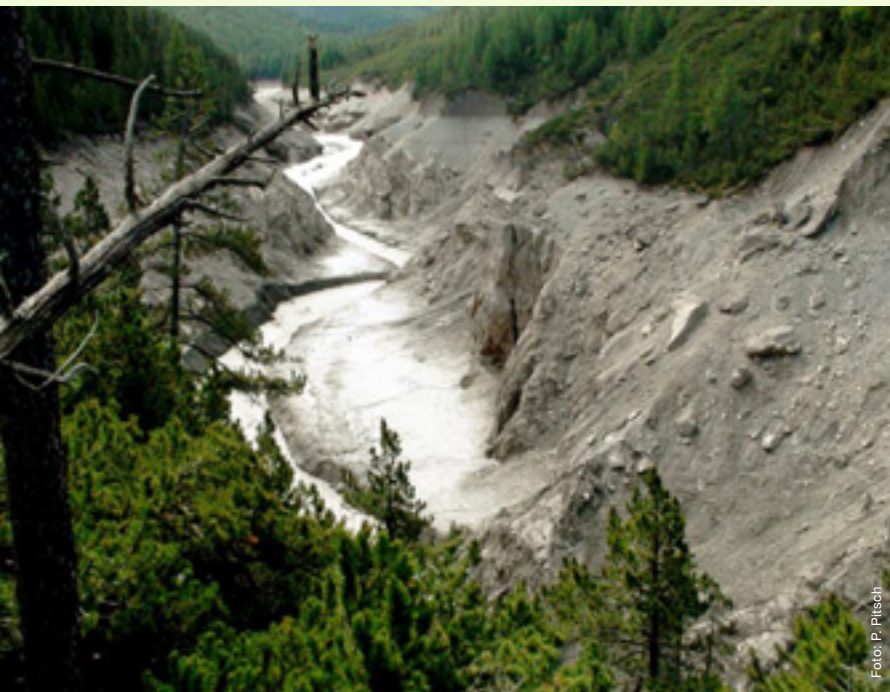
Abbildung 5 Blick in das geleerte Ausgleichsbecken Ova Spin mit beachtlichen Ablagerungen auf der Talsohle.
