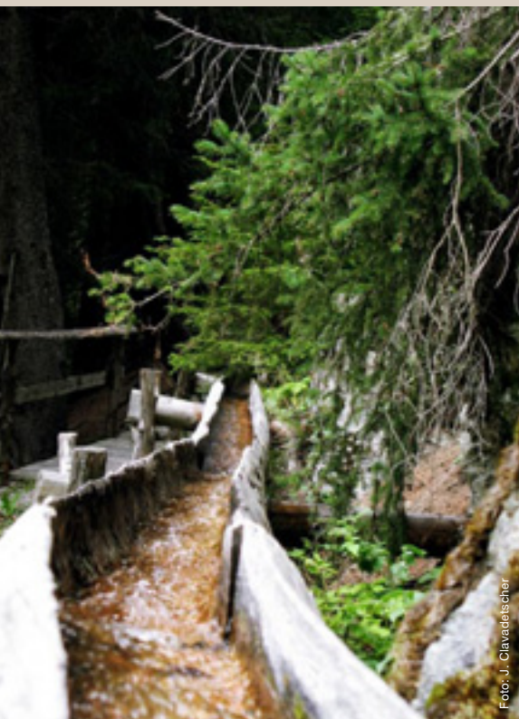
Früher wurden die Rundholzkanäle oft aus Arvenholz hergestellt.
