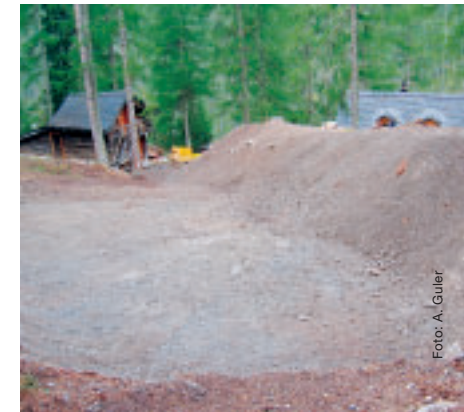
Neu errichteter Damm zur Ablenkung von Murgängen oberhalb des Blockhauses Cluozza
