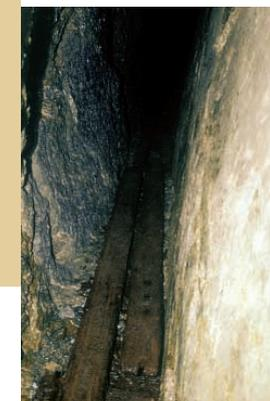
Die engen Stollen sind teilweise ausgebaut und mit Holzschienen für den Abtransport des Gesteinsmaterials auf Schlitten ausgestattet.
