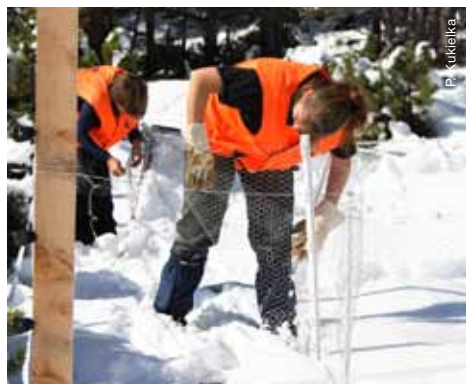
Reparaturarbeiten an Zäunen nach Wintereinbruch.
