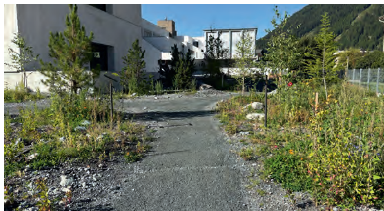
4 Monate nach dem ersten Spatenstich hat sich schon einiges verändert ... (Fotos: SNP, Stefan Trieb)
