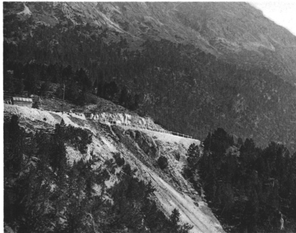
24. - Le barrage de l'Ofenpass
