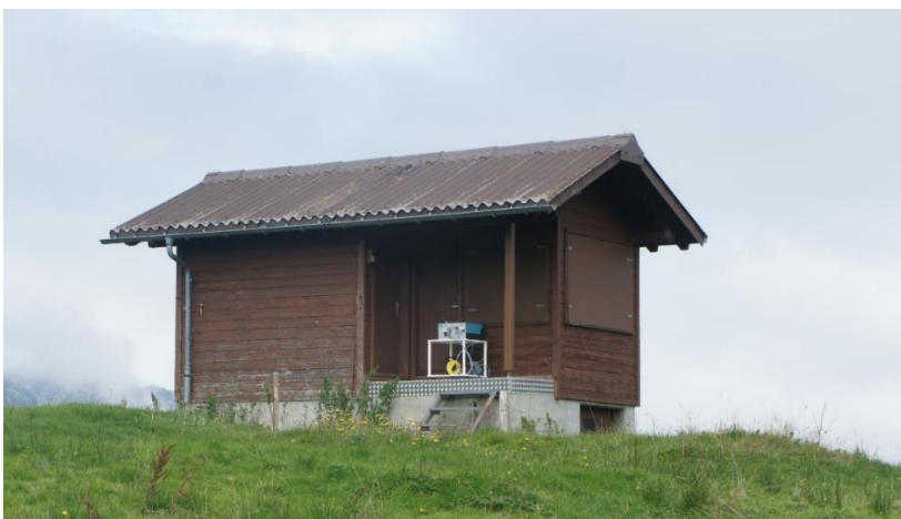
Abbildung 6: Husegg, Skihäuschen mit stationärem Messgerät vor der Türe
