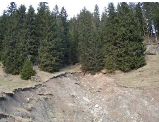
Abbildung 4.9: Rutschung auf der Alp Spittel aus einiger Entfernung. (Bild J.Krummenacher)
