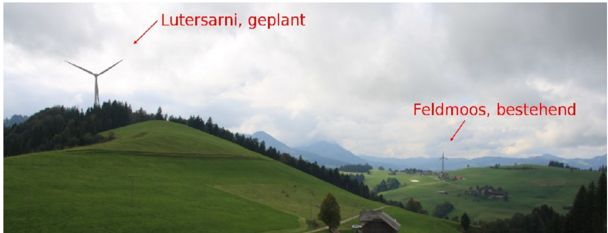
Die Windenergieanlagen Feldmoos und Lutersarni vom Hof "Ober Blattig" aus gesehen (Fotomontage). (Bild aus "Vorprüfung zur Zonenplanänderung Windenergieanlage Lutersarni", tsp Raumplanung)
