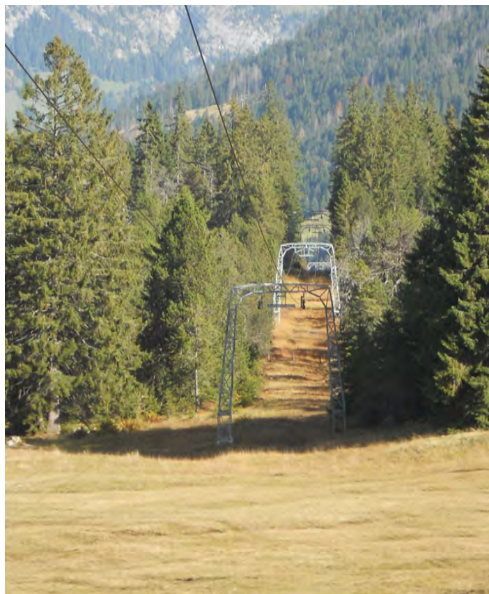
Abb. 5: Skiliftanlage oberhalb von Sörenberg. Quelle: Eigenes Bild.
