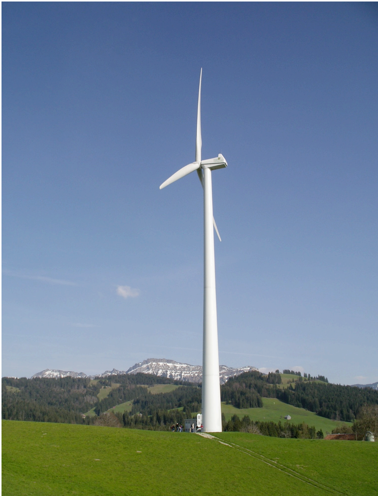
Abbildung 11: Windkraftwerk von Westen
