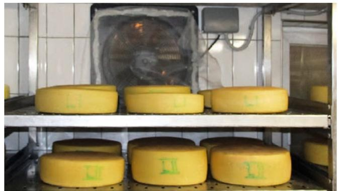
8.5 Fahrzeugkühler mit Ventilator und Fliegennetz im Lichtschacht eines Fensters.
