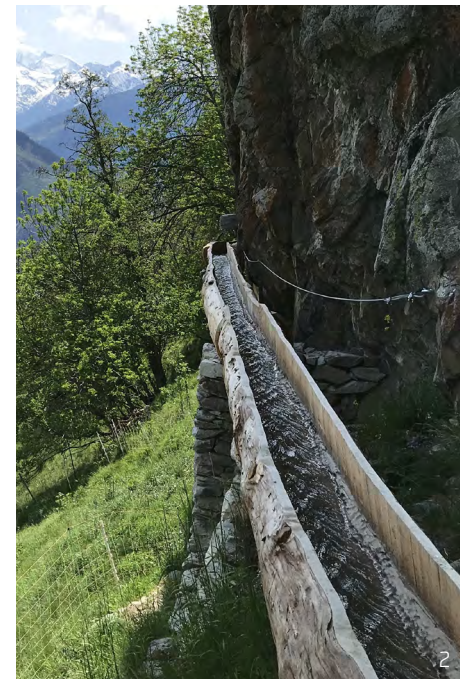
Abbildung 2: Wasserwasserleitungen werden je nach Region auch Suonen, Wasserleiten oder bisses (franz.) genannt. Das Wasser wird meist aus Bächen abgezweigt, die durch höhergelegene Quellen, Schneefelder und Gletscher gespeist werden. Über teils spektakuläre Bauten wird es in tiefere Lagen geleitet, wo es zur Bewässerung von Wiesen, Reben oder Obstkulturen genutzt wird. (Foto: Karina Liechti)
