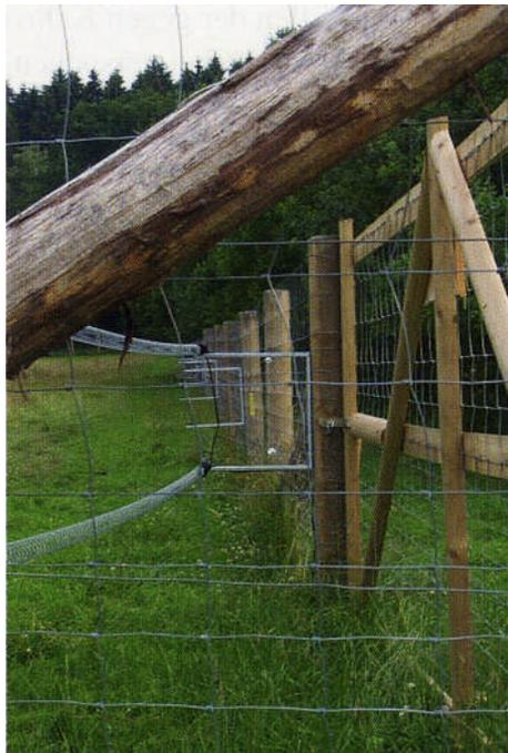
**Abb. 23: Wisentzaun in Hardehausen. In ca. 50 cm Abstand vom Maschendrahtzaun ist ein doppelter Elektrozaun gespannt, durch den 8'000 Volt fließen. Diese Konstruktion hat sich bisher gut bewährt. Der Elektrozaun muss allerdings regelmässig kontrolliert werden. Quelle: Glunz (2007)**
