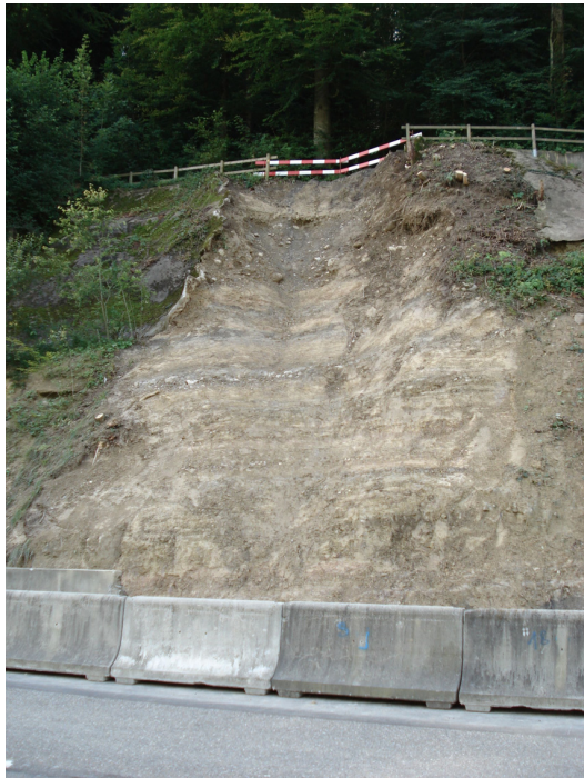
(a) Rutschung an der Sihlstrasse. Koordinaten LV95: E= 2'686'256 / N= 1'231'326. (Aufnahme: 23. 8. 2007)
