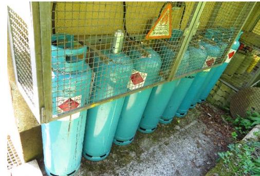
Abbildung 41: Gasflaschen für die Warmwasseraufbereitung (Foto: Linda Frei)
